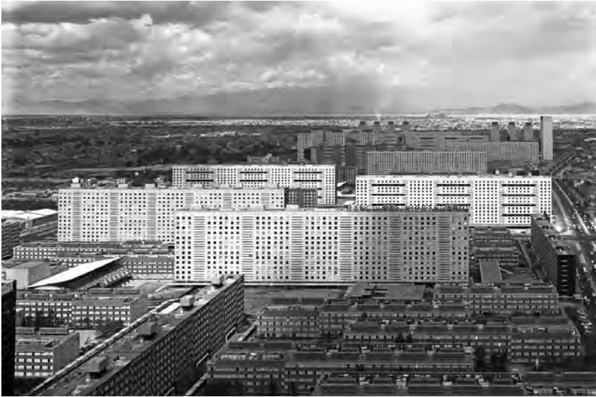
9. Vista panorámica del Conjunto Urbano Nonoalco-Tlatelolco, 1966. Foto: Armando Salas Portugal. Reproducción autorizada por la Fundación Armando Salas Portugal.
