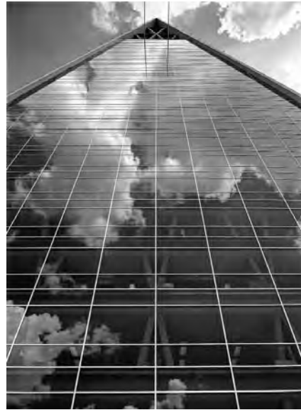
6. Fachada del edificio de Banobras, 1966. Foto: Armando Salas Portugal. Reproducción autorizada por la Fundación Armando Salas Portugal.
